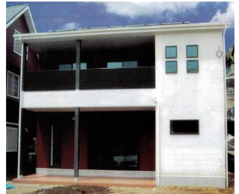
スマートベラシリーズ (3商品) 停電レスZEH 即日完売。現場看板だけで2棟売れた家
